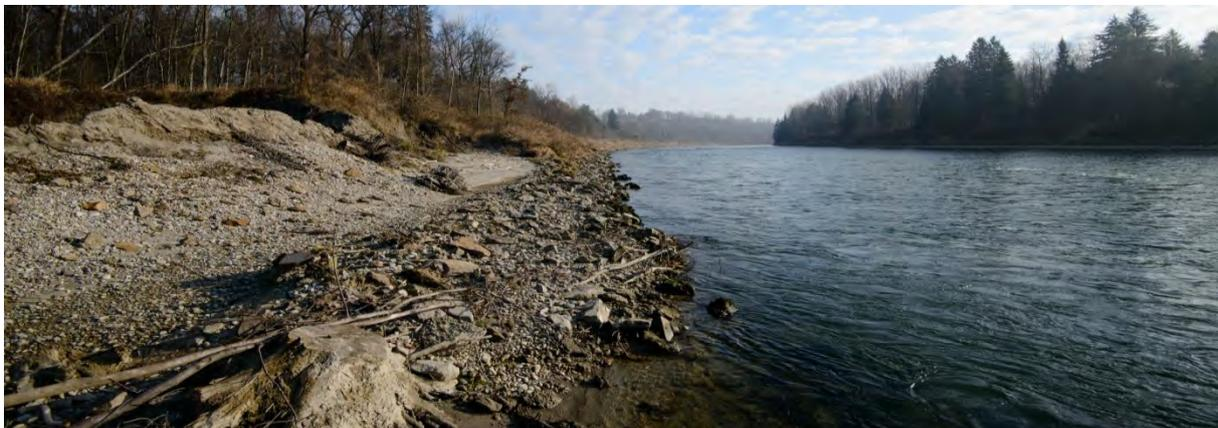
Abbildung 5-2: Aufweitungsmaßnahmen über weiche Ufer, das Geschiebe wird bei höheren Wasserständen mobilisiert (Foto: REVITAL)
