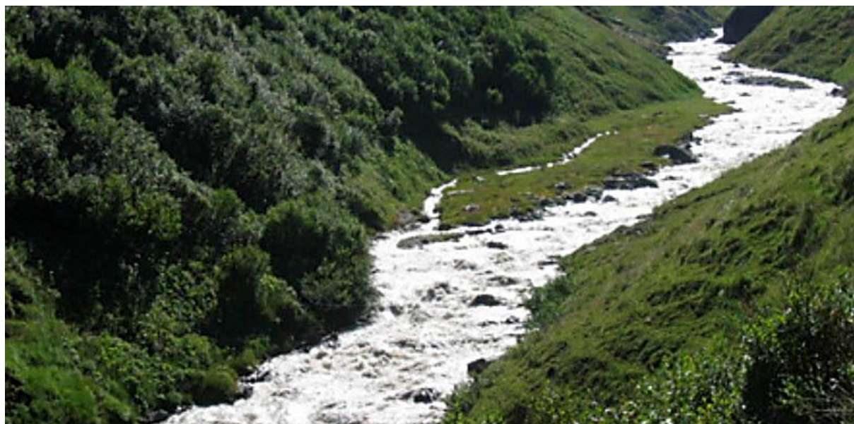
Der Froßnitzbach, der aus dem Nationalpark Hohe Tauern fließt, soll nach neuesten Plänen ein Kraftwerk der Tiwag antreiben. Foto: WWF/Kohler
