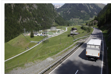
Das Matreier Tauerntal mit Felbertauernstraße, Stromleitung und der Pumpstation Gruben der Transalpinen Ölleitung, die Seveso-3-Gebiet ist. Hier soll das neue Kraftwerk entstehen. © Wolfgang Retter
