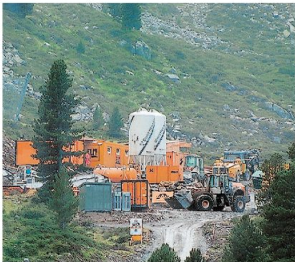
Die Baustelle im Längental ist deutlich sichtbar. Laut Tiwag handelt es sich um Erkundungsmaßnahmen für die Kraftwerkserweiterung. Foto: Mair
