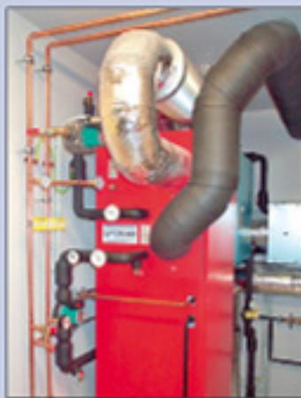
*Haas holt sich auch Wärme von der Erde. Die Wärmepumpe wird mit Strom von der Photovoltaikanlage gespeist.*
