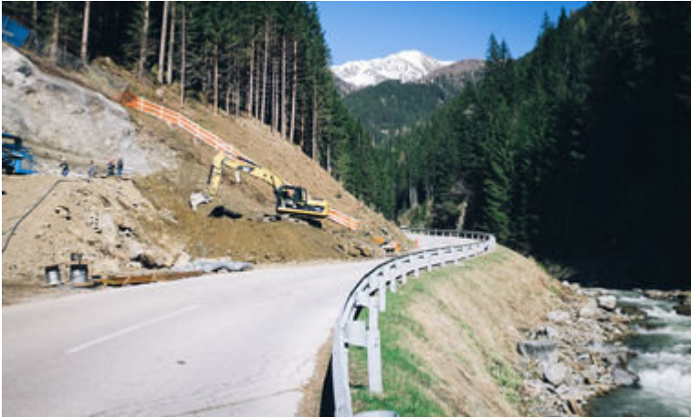
Die Bauarbeiten laufen: Künftig wird der Winkeltalbach nur mehr 20 Prozent der ursprünglichen Wassermenge führen Foto © Michael Egger
